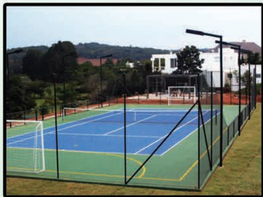
Sistema Iluminação "Day Light"
